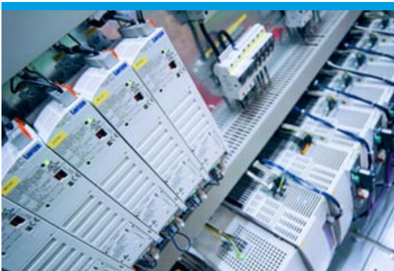
Sämtliche Bewegungsfunktionen in den Antriebsreglern sind mit CoDeSys programmiert.
