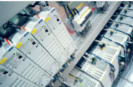
Blick in den Schaltschrank: Frequenzumrichter der Reihe 8200 vector und Servo-Umrichter der Reihe treiben die Motoren an.
